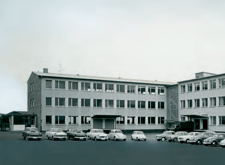
1960 новое здание завода в Люнене
